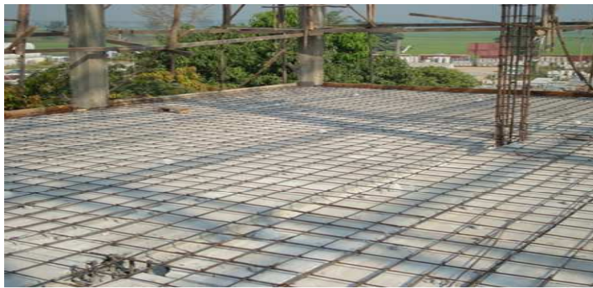
รูปที่ 19 แสดงการวางเหล็กเสริมตะแกรงป้องกันการแตกร้าว
