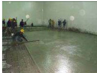
รูปที่ 20 แสดงการเทคอนกรีตทับหน้า และการปรับแต่งผิวหน้า
