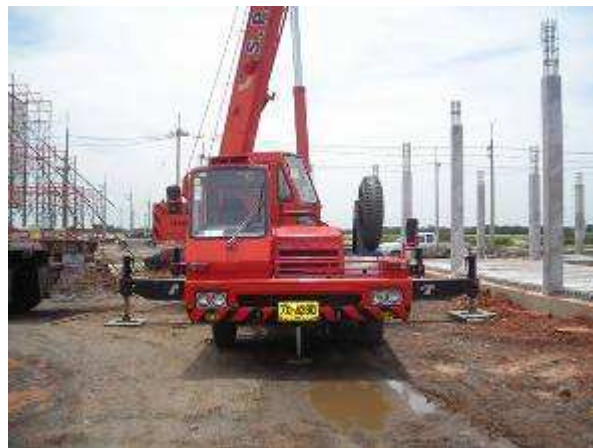
รูปที่ 9 รถเครนที่ติดตั้งบริเวณหน่วยงานก่อสร้าง
