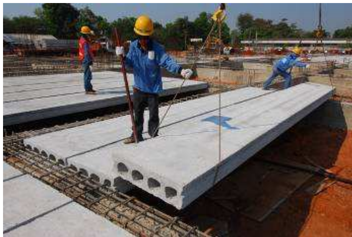
รูปที่ 14 แสดงการวางแผ่นพื้นคอนกรีตสำเร็จรูป
