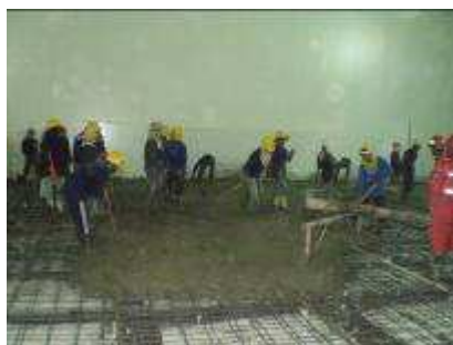
รูปที่ 20 แสดงการเทคอนกรีตทับหน้า และการปรับแต่งผิวหน้า
