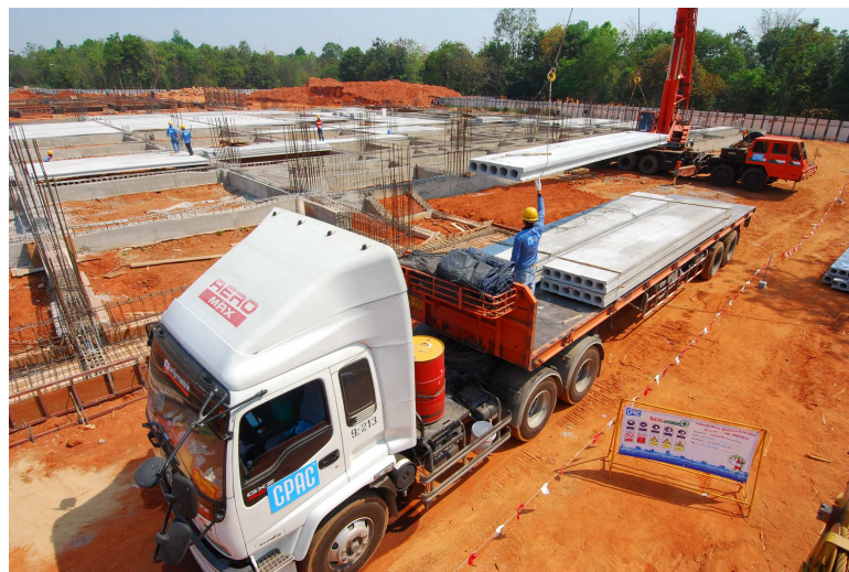
รูปที่ 10 รูปแสดงตำแหน่งของรถขนส่งที่เหมาะสมกับการใช้เครน
