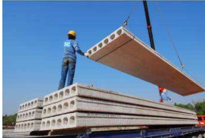
รูปที่ 11 แสดงการคล้องสลิงเพื่อยกแผ่นพื้นคอนกรีตอัดแรงชนิดกลวง
