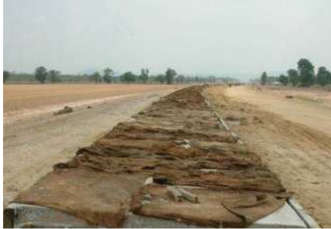
รูปที่ 33 แสดงการบ่มคอนกรีตด้วยกระสอบชุบน้ำ
