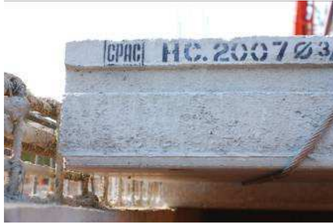
รูปที่ 15 แสดงการวางแผ่นพื้นคอนกรีตสำเร็จรูป Hollow Core บนหลังคา
