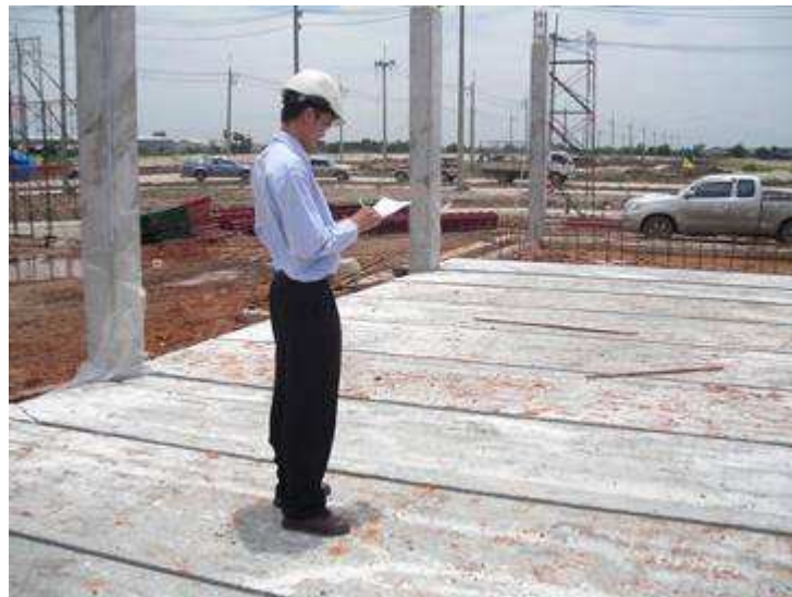
รูปที่ 16 พนักงานทำการตรวจงานติดตั้ง
